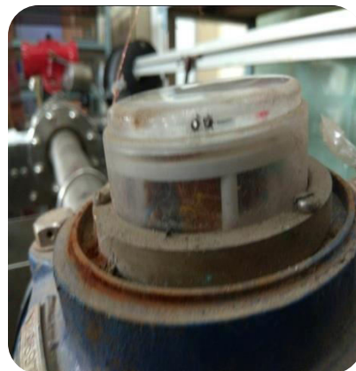
121, 129, 130 дүгээр ус дулаан дамжуулах төв тоолуурын толгойг гадны биетээр гацаасан
